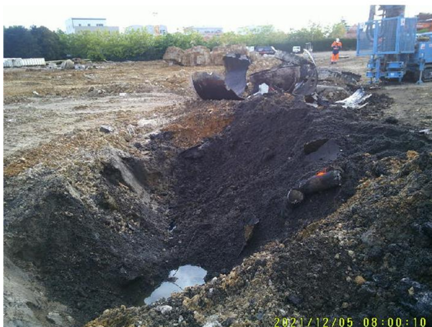
Photo n°2 – Dalle béton imbibée d'hydrocarbures
