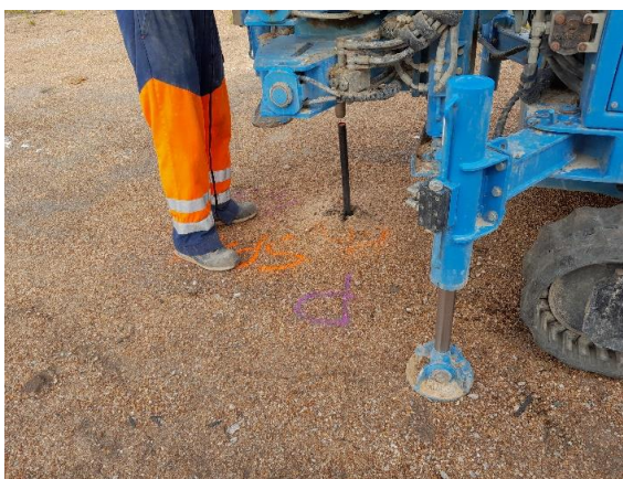
Piezair en place (avant cimentation)
