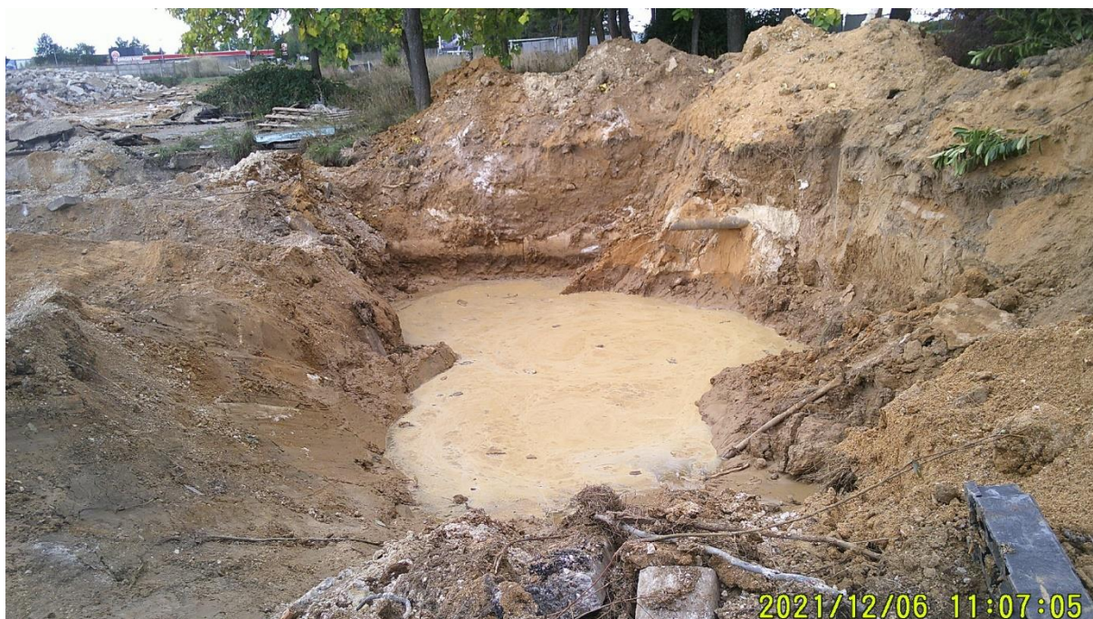
Photographie de la fouille après retrait de la cuve de carburant
