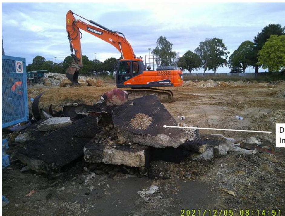
Photo n°2 – Dalle béton imbibée d'hydrocarbures
