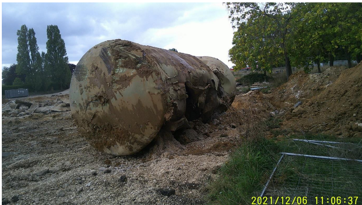
Cuve de carburant excavée et retirée de la fouille
