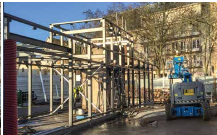
Début mars, l'ossature de la nouvelle structure était finie.
