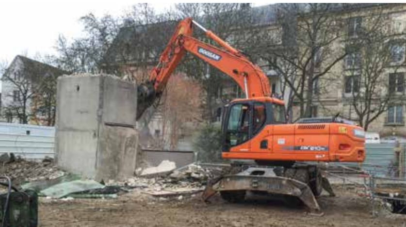
Début février, les pelles curaient la sortie piétons du parking, ne laissant que la cage d'ascenseur et la cage d'escalier.
