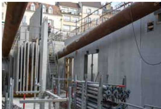
Les cloisons préfabriquées sont stockées sur site et posées au fur et à mesure de la progression des bâtiments du Pôle administratif.
