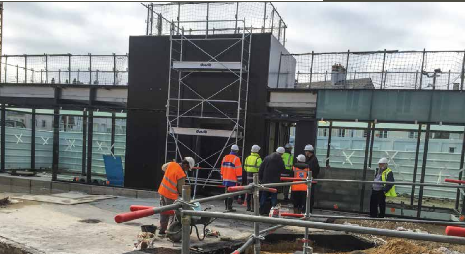
La nouvelle sortie piétons du parking et son édicule, en voie d'achèvement.
