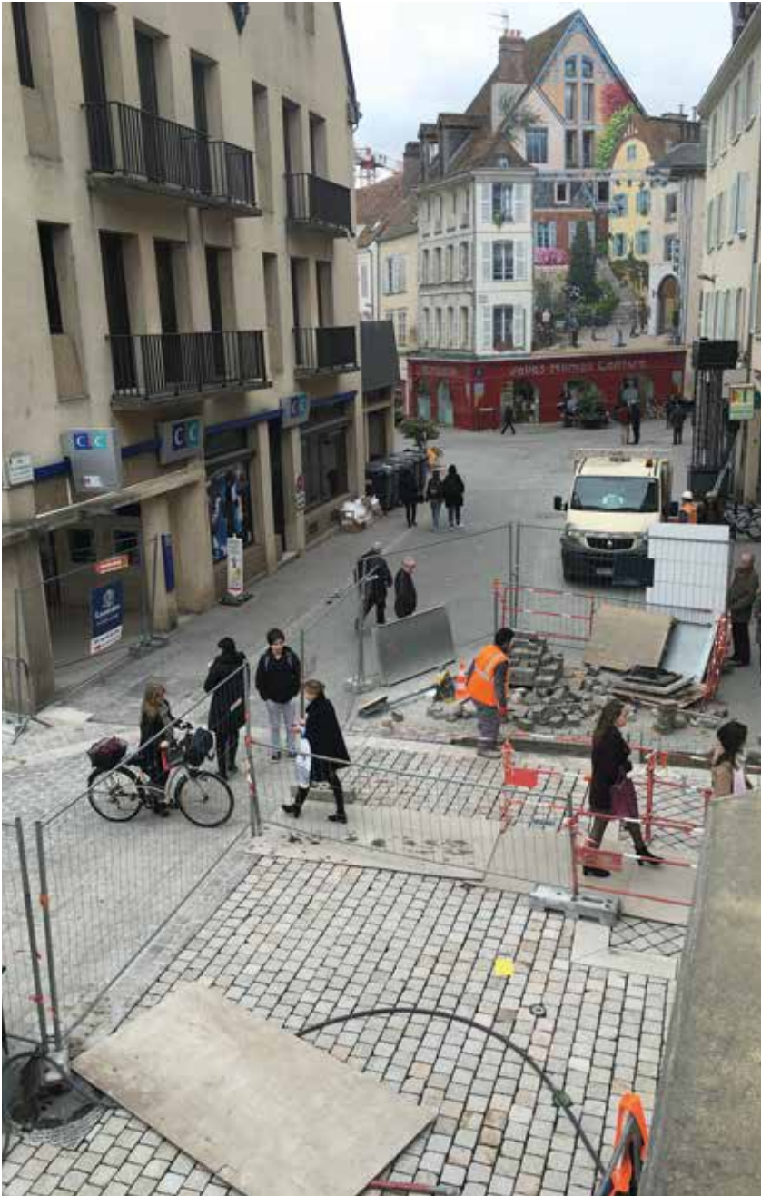
Le carrefour à l'angle des rues de la Volaille, du Maréchal-de-Lattres-de-Tassigny et Marceau.
