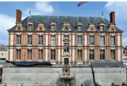
L'hôtel Montescot est solidement campé sur les nouveaux contreforts des bâtiments du Pôle administratif.
