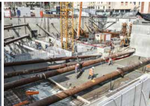
Fin mars, le niveau R-2 du Pôle administratif est pratiquement achevé.
