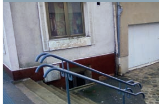
Pose de mobilier PMR.
