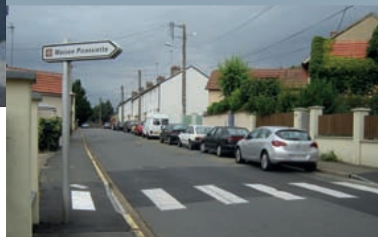
Abaissement des trottoirs et pose de bandes podotactiles.
