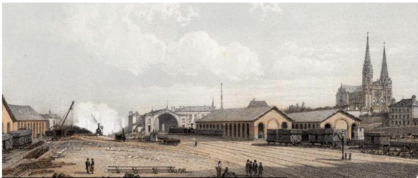
Vue depuis les ateliers (à g.). Au second plan à d. : les hangars à marchandises. A l'arrière plan, on distingue nettement comment la halle de la gare couvre les quais et les voies. Médiathèque de Chartres.
