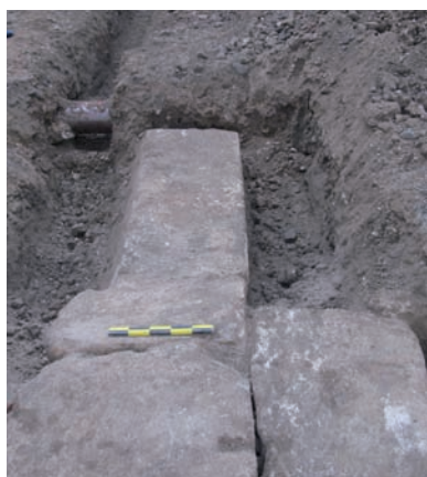
Blocs calcaires des fondations de la tour du château sous les halles de la place Billard, vue vers le sud avec mire de 50 cm. P. Gibut
