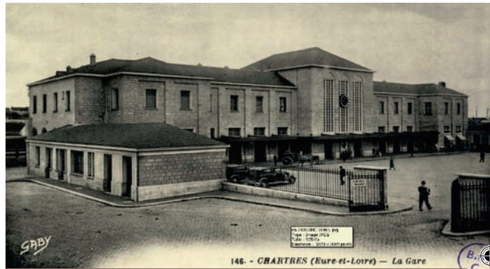
De l'ancienne gare, la nouvelle a gardé l'organisation en un bâtiment tricorset une place des voyageurs avec enceinte. Médiathèque de Chartres.Ile-de-France, tous droits réservés.
