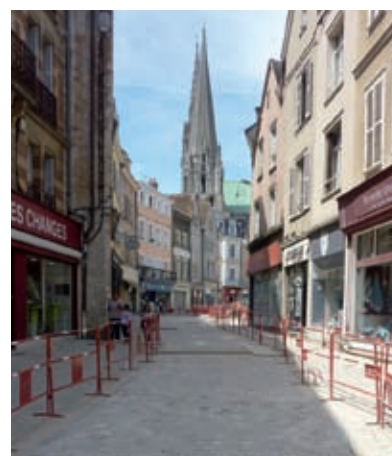
Aménagements de voirie terminés dans le bas de la rue des Changes
