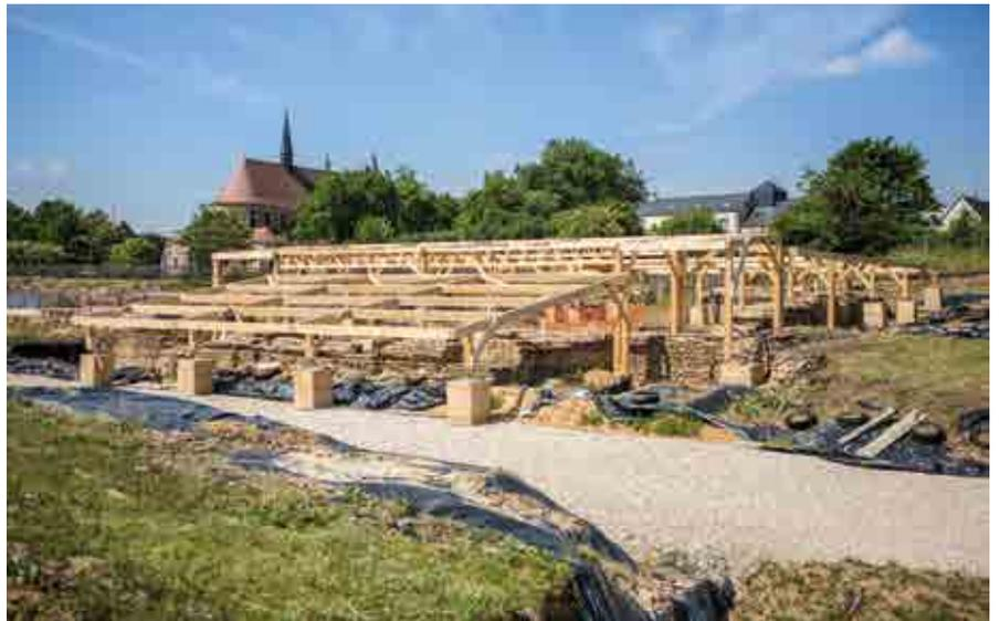
verte d'une toiture en acier ondulé de 400m<sup>2</sup> évoque la forme du pavillon d'angle et de l'exèdre. La légèreté de la structure assure son intégration au site. L'espacement des poteaux de soutènement, de hauteurs variables, permet aux chercheurs de continuer à travailler sur les vestiges.
