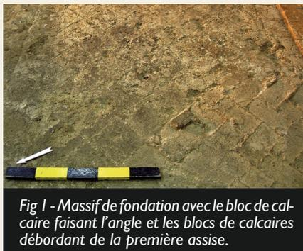
Fig 1 - Massif de fondation avec le bloc de calcaire faisant l'angle et les blocs de calcaires débordant de la première assise.
