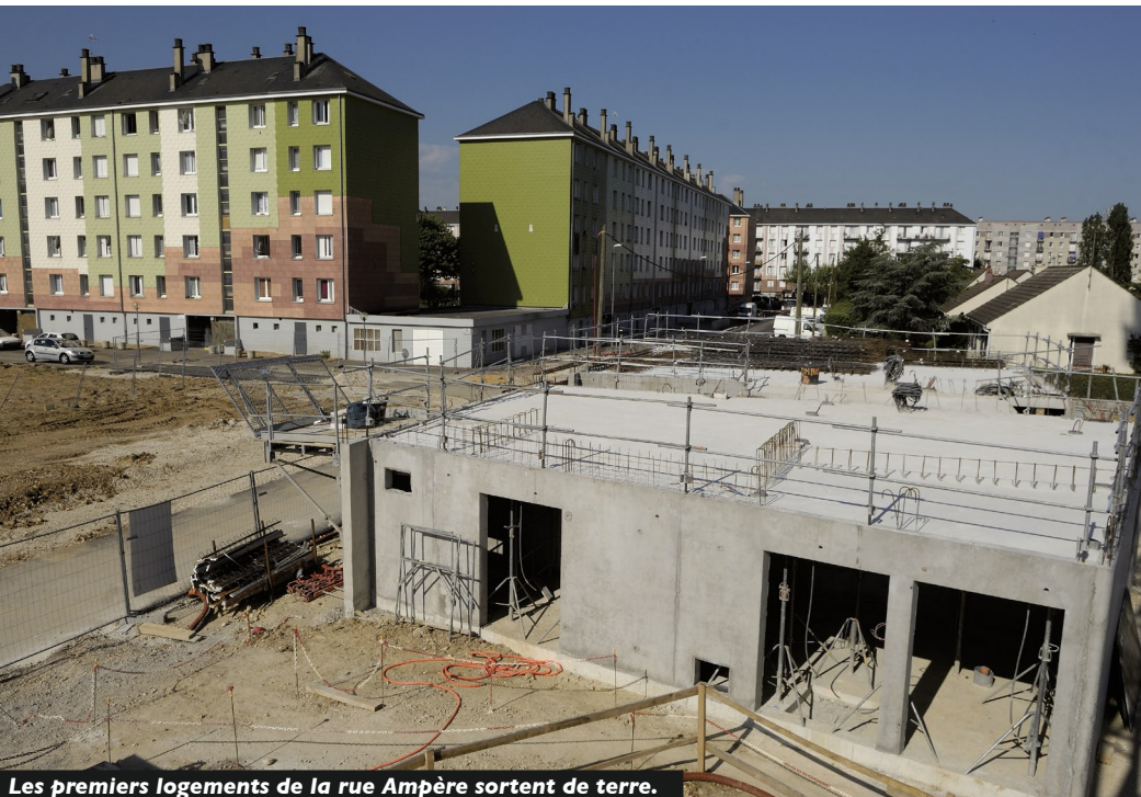
Les premiers logements de la rue Ampère sortent de terre.
