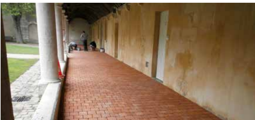
Ecole de musique et de danse : surélévation du sol de la coursive extérieure pour accéder aux 3 salles de musiques du fond de la cour
