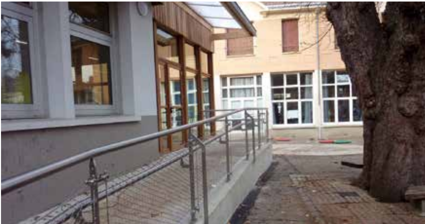
École élémentaire Jules-Ferry : restaurant avec rampe PMR, création de 2 rampes accès aux 2 entrées
