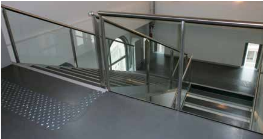
Médiathèque : pose de clous podotactiles pour les non-voyants sur l'escalier principal
