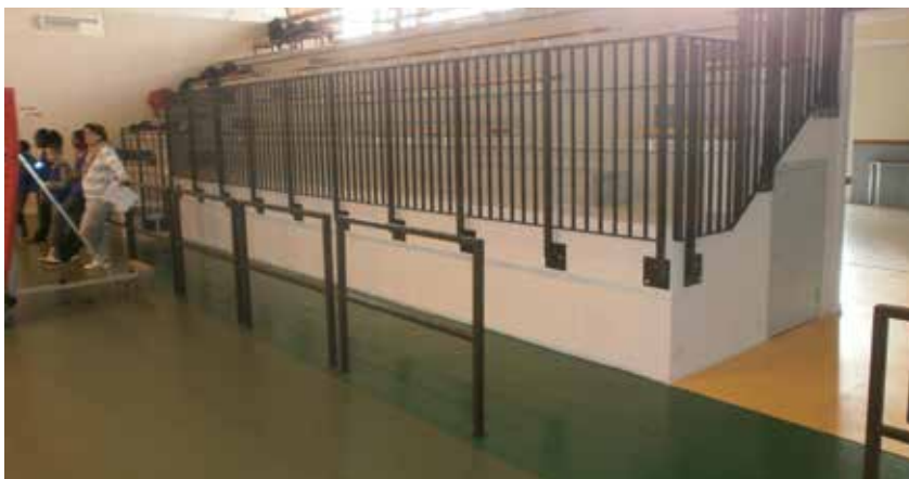
Complexe sportif de la Madeleine : création d'une ouverture dans les tribunes donnant sur le hall d'entrée et d'un espace réservé aux fauteuils dans la salle. Amélioration de la sécurité de tous par la création d'une sortie supplémentaire
