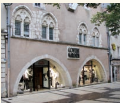
Des arches qui plongent sans doute profond sous terre.
