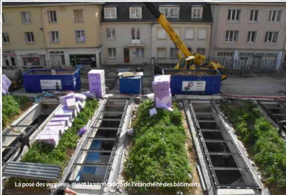
La pose des verrières, avant la vérification de l'étanchéité des bâtiments
