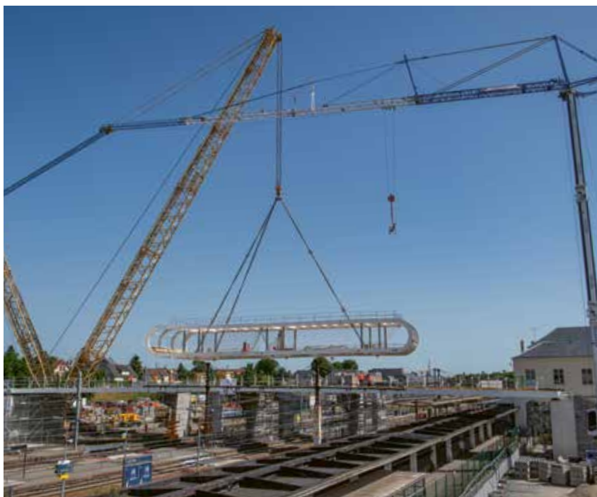
La pose du tablier et de l'estacade de la passerelle a constitué un moment fort du programme Pôle Gare
