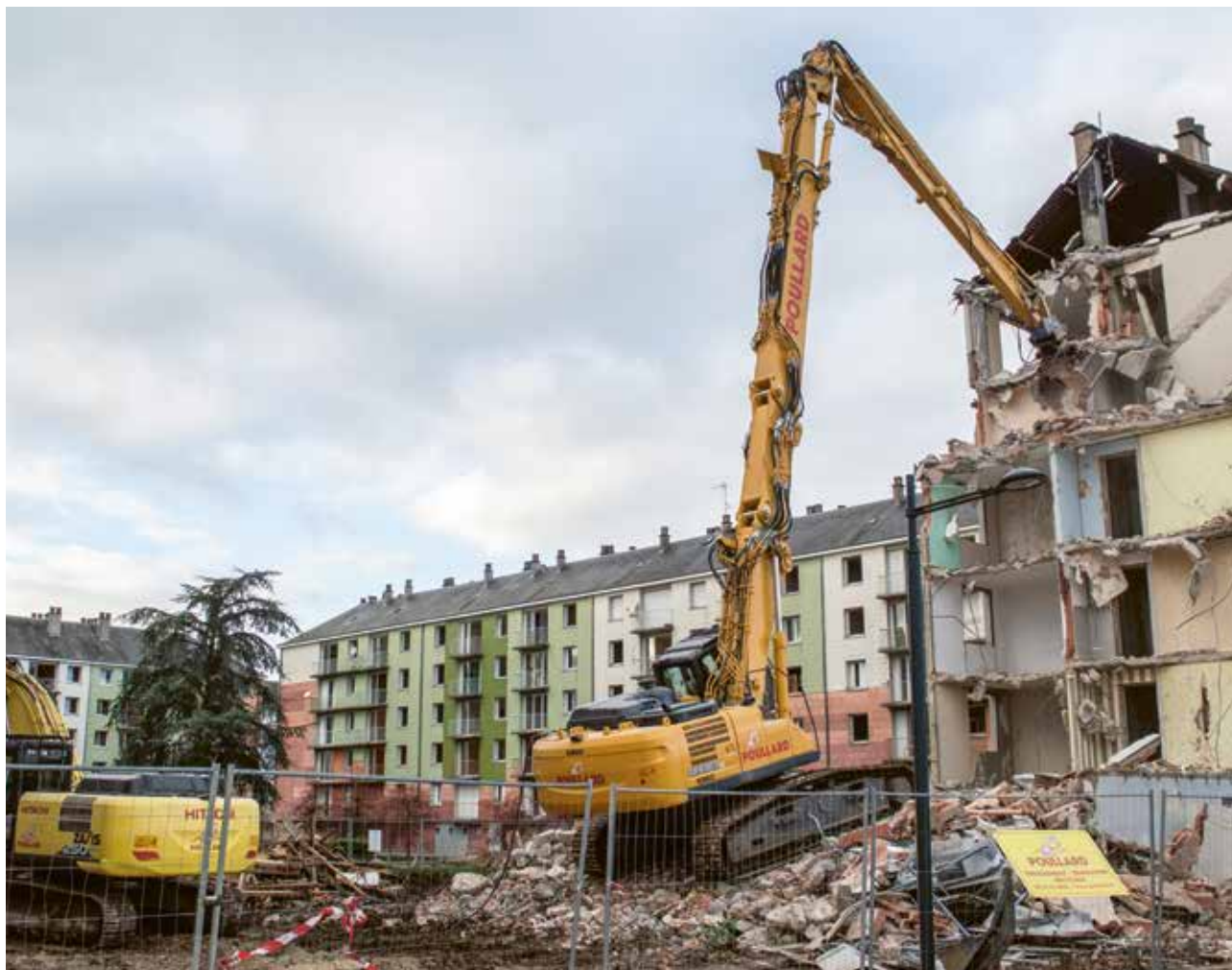
Rue Lavoisier : la démolition de bâtiments osolètes précède la construction de programmes neufs
