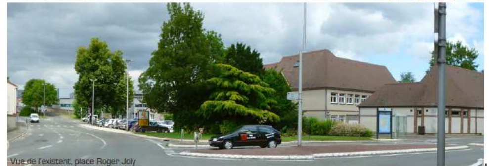
Vue de l'existant, place Roger Joly
