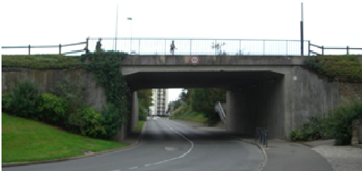
Passage dénivelé du boulevard de la Courtille sur la rue Mendès France
