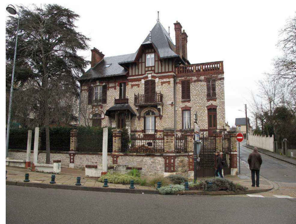
Photographie 4 : Habitation remarquable à préserver au titre de l'article L.123-1-5-7 du code de l'urbanisme, d'après le PLU de Mainvilliers
