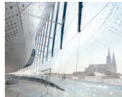
FIGURE 15 : VUE DU HALL, AVEC SA FAÇADE VITREE SERIGRAPHIEE
