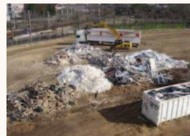
Le chantier, les installations ainsi que les abords du chantier seront nettoyés en permanence.
