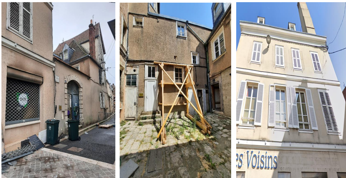
Figure 4 ; Photographies de l'ensemble immobilier sis 12 rue de l'Épervier – 29 rue de la Pie (Source : Visites, 2021 et 2022)
