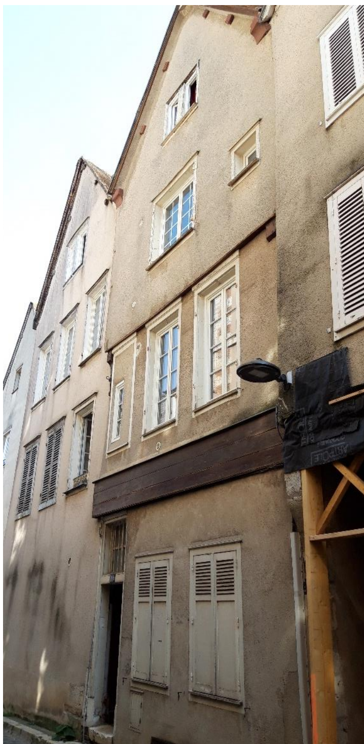
Figure 4 (ci-contre) ; Photographie de l'immeuble sis 10 rue Muret (Source : Service Habitat et Solidarités 2022)
