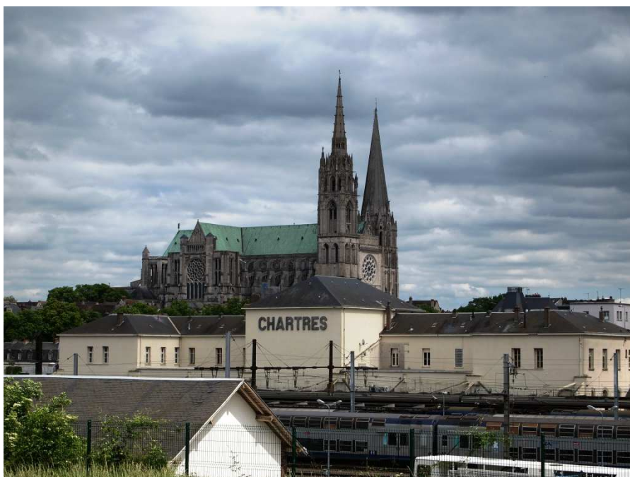
Vue depuis la rue du Chemin de fer
