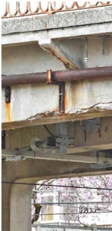
parmi les causes de fermeture du pont; la qualité du béton qui s'effrite en surface.
