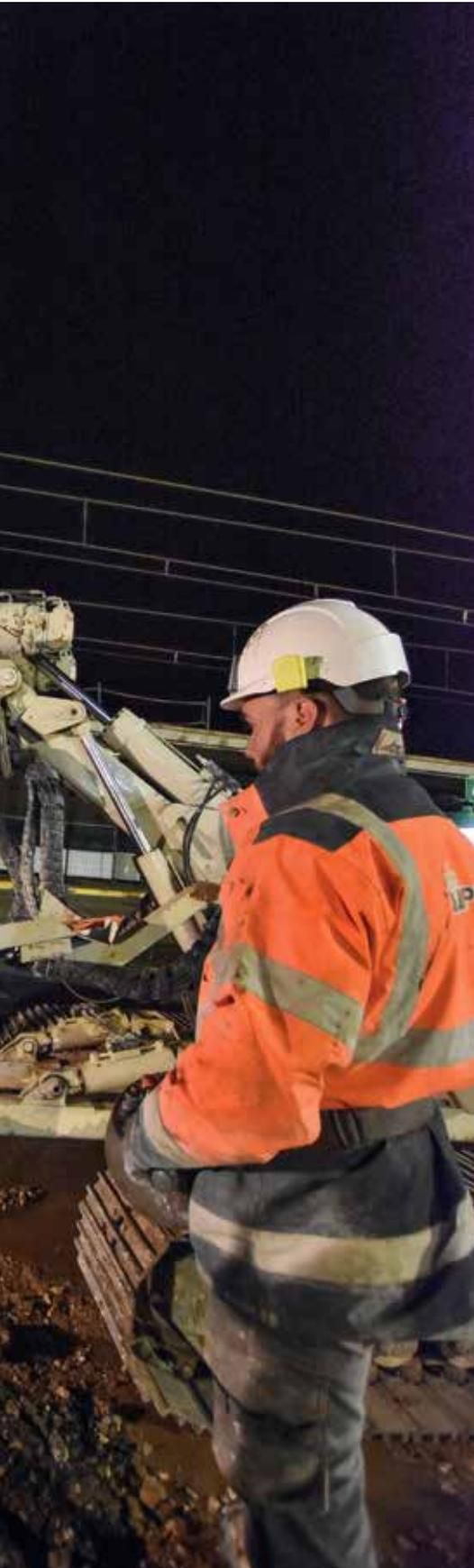
Les forages des micro-pieux se sont faits la nuit sur les quais, pour préparer l'édification des piles de la passerelle.
