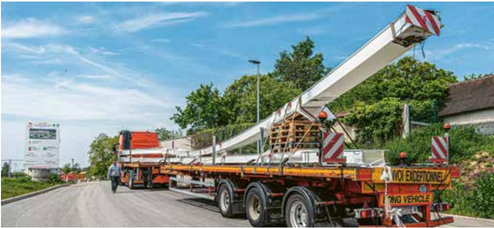
Les éléments préfabriqués du tablier de la passerelle ont nécessité toute une logistique pour leur acheminement et leur installation sur la zone chantier
