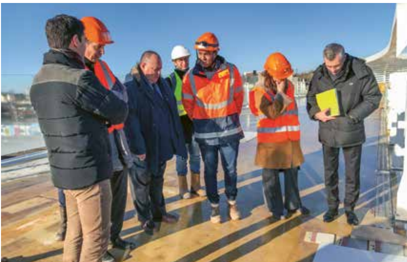
Réunion de chantier sur le futur revêtement de la passerelle.
