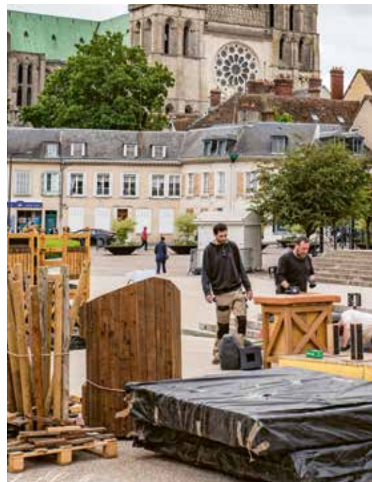
Le montage du Parcours du chevalier.
