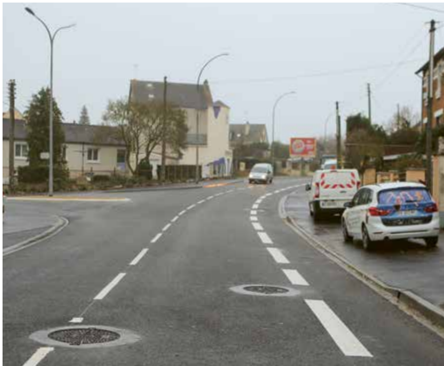
Une nouvelle piste cyclable a été réalisée rue de Sours.
