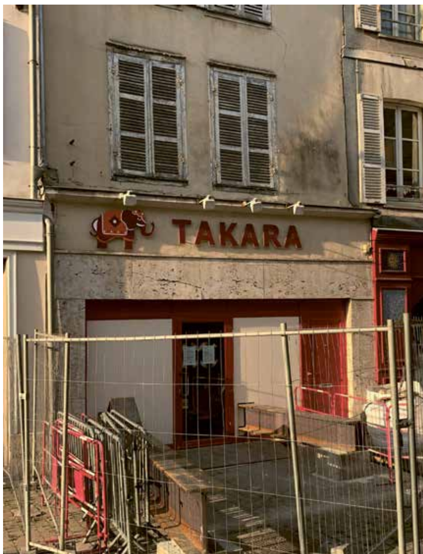
Le 11 rue de la Volaille, interdit à l'habitation depuis décembre 2018
