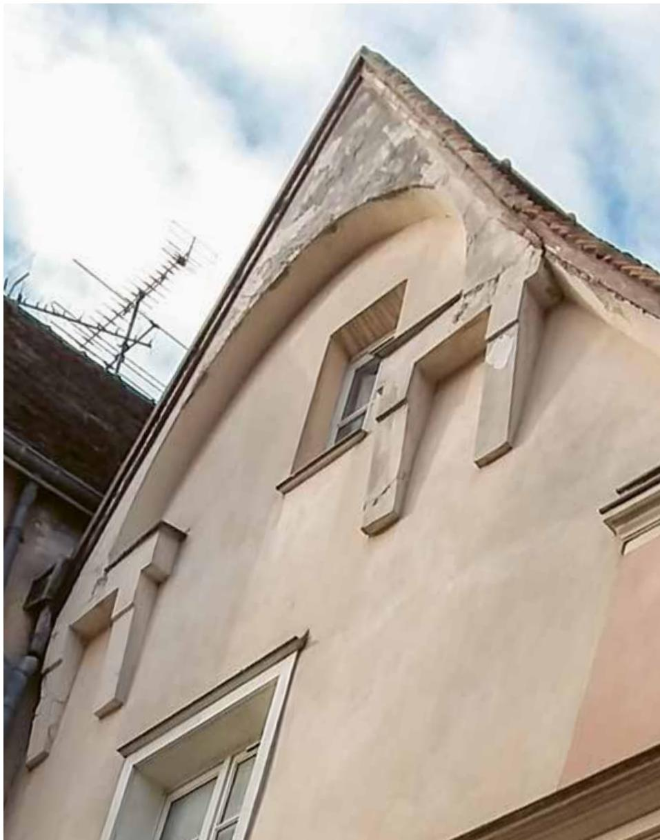
Au 32, rue de la Poêle Percée, la partie de la charpente débordante avait été recouverte par un enduit de ciment. L'opération Façades a permis de remettre en valeur cet élément architectural.
