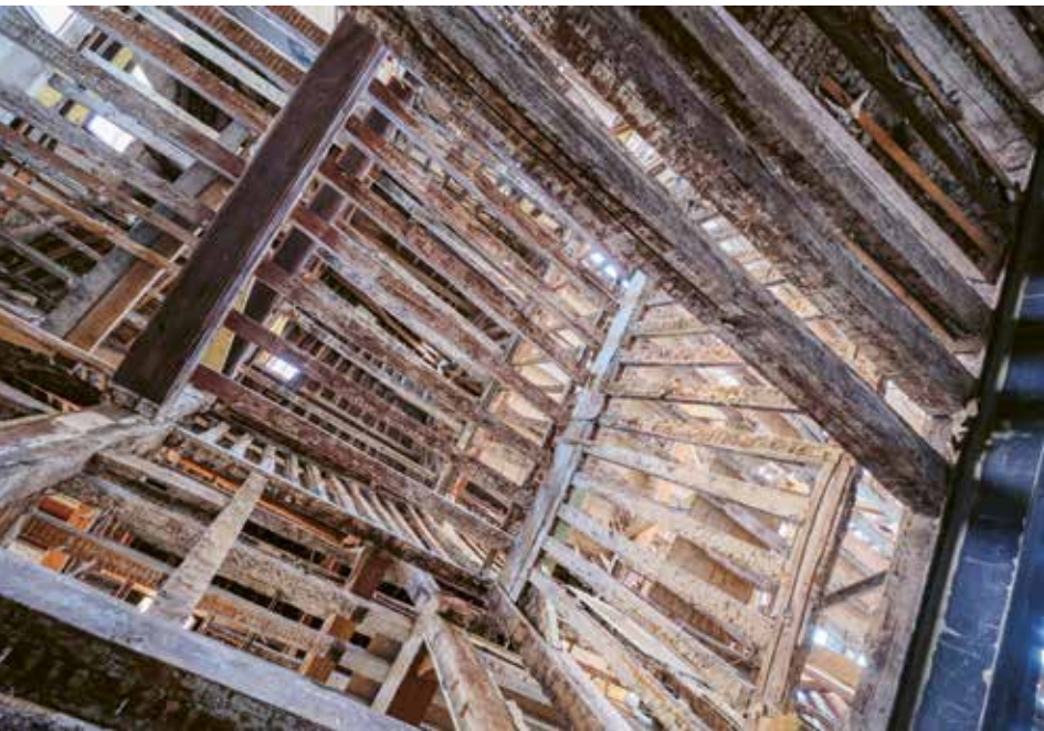
L'immeuble à l'angle de la place Marceau et de la rue de la Pie entièrement désossé avant réhabilitation
