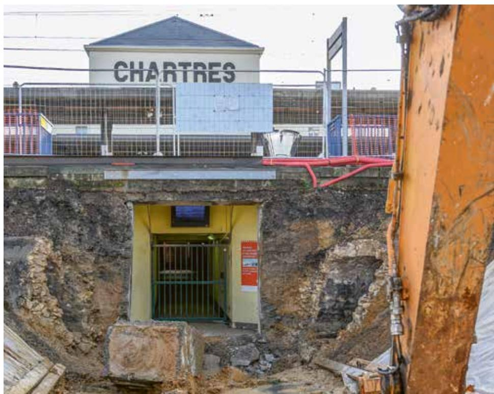
**L'**aiguille du chronotrotte. Le 2 novembre a démarré le percement du tronçon de tunnel qui établira la connexion entre le niveau -2 du futur parking Q-PARK du Pôle Gare, et le souterrain d'accès aux quais. Un chantier chronométré puisque, comme le met en évidence Nicolas Ducrot, responsable travaux du chantier Q-PARK, « *quand une intervention qui concerne le périmètre de voies ferrées nécessite une*
