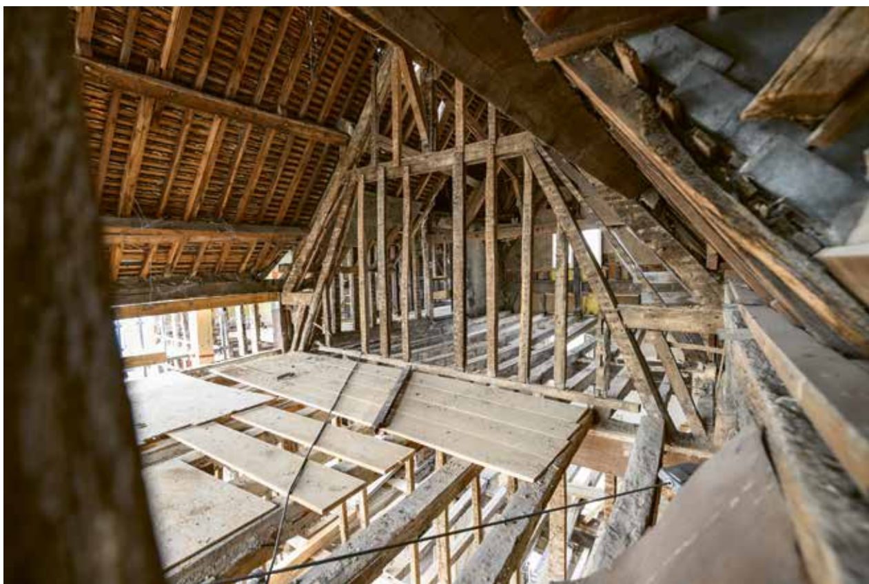
La précieuse structure en bois de l'immeuble du 2-4 place Marceau a été conservée
