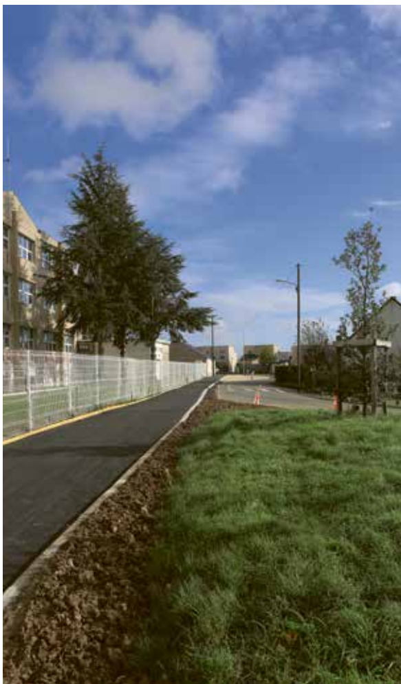
Les aménagements de la rue du Commandant Chesne
