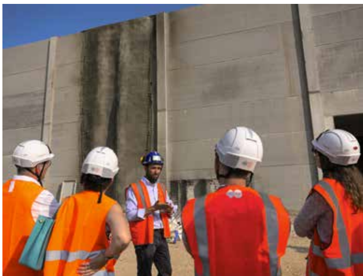
La course traversera le chantier du futur parc des expositions.
