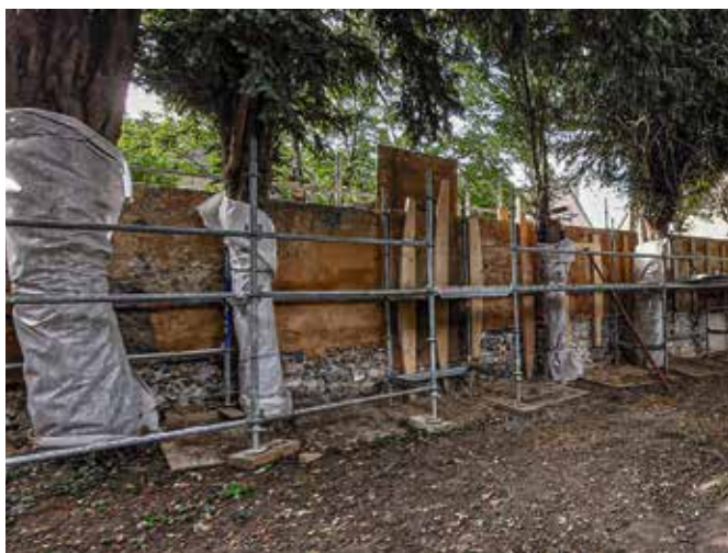
La restauration du mur de séparation côté sud.
