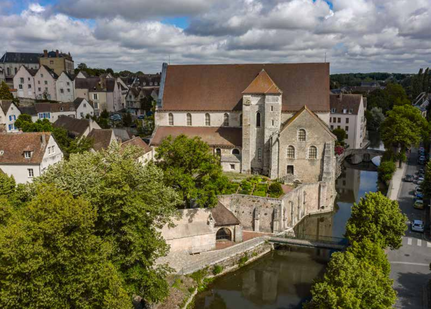
Vue aérienne de la collégiale Saint-André, qui retrouvera bientôt ses vitraux.
