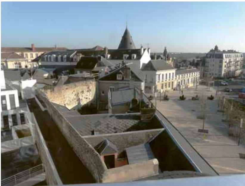
Mur de la ville inséré dans la construction de l'entrée Saint-Michel.
