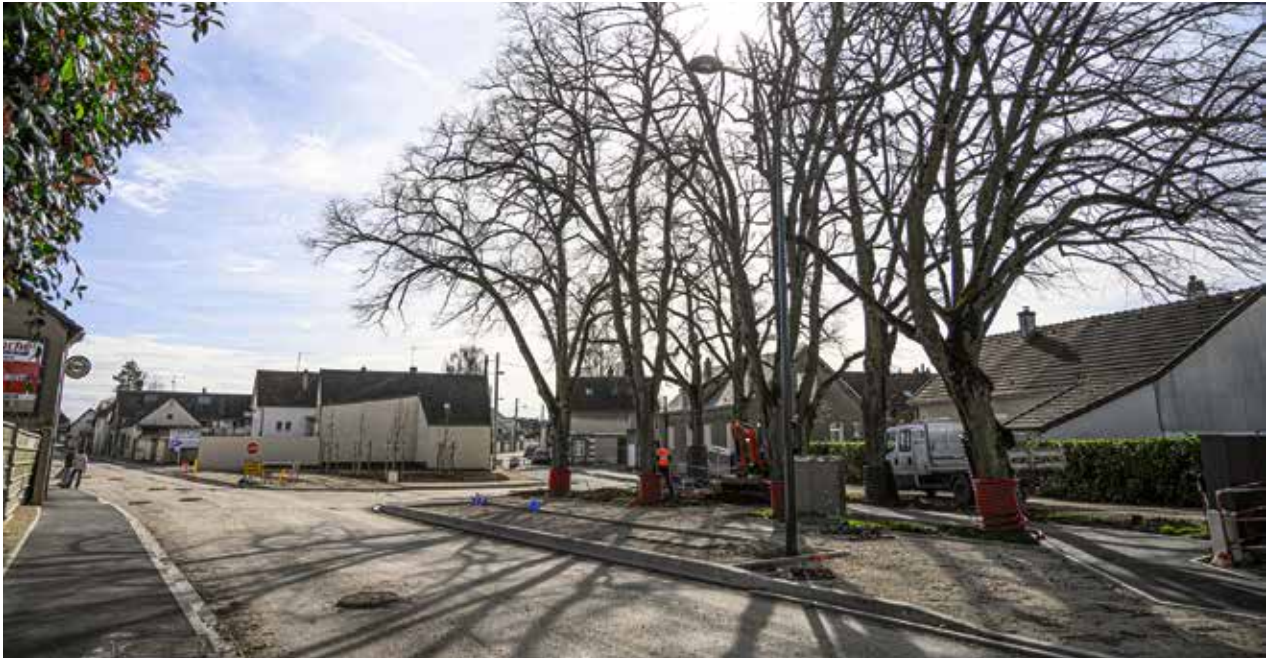
Vue des aménagements en cours de réalisation sur la rue d'Allonnes, au croisement de la rue des Chaises.
