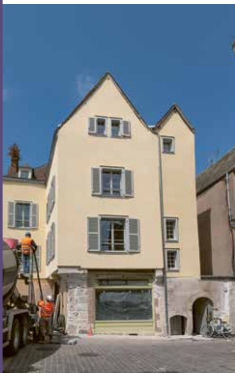
L'immeuble situé au 2-4 place Marceau, pendant son opération de réhabilitation.
