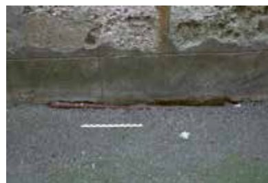
Un soulpirail bouché : sans aération, la cave retient l'humidité qui s'y accumule.
