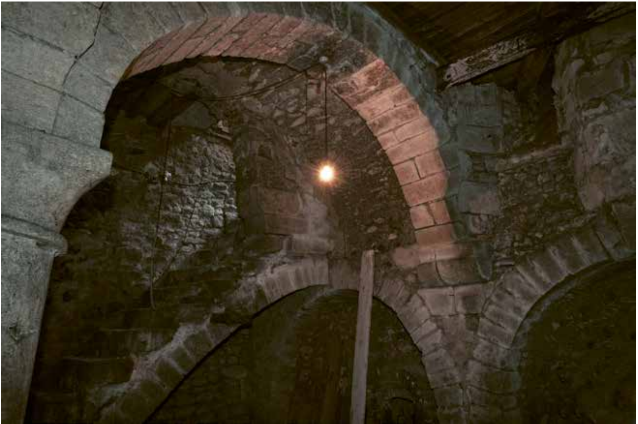
Des niveaux de caves.
