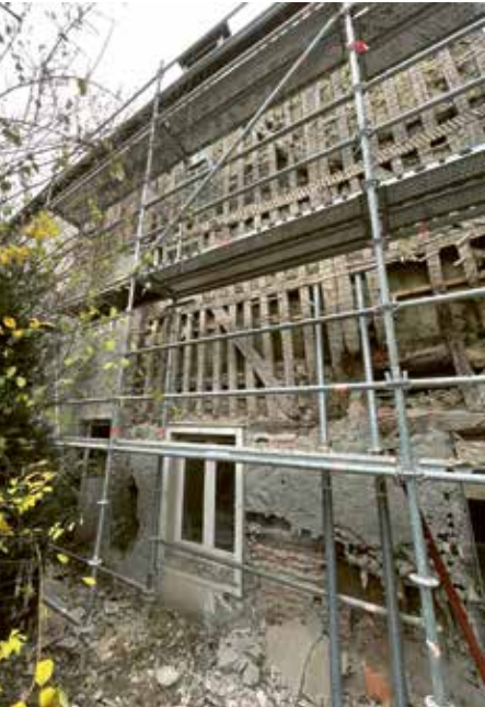
L'immeuble situé au 19, rue Saint-Pierre avant les travaux.
