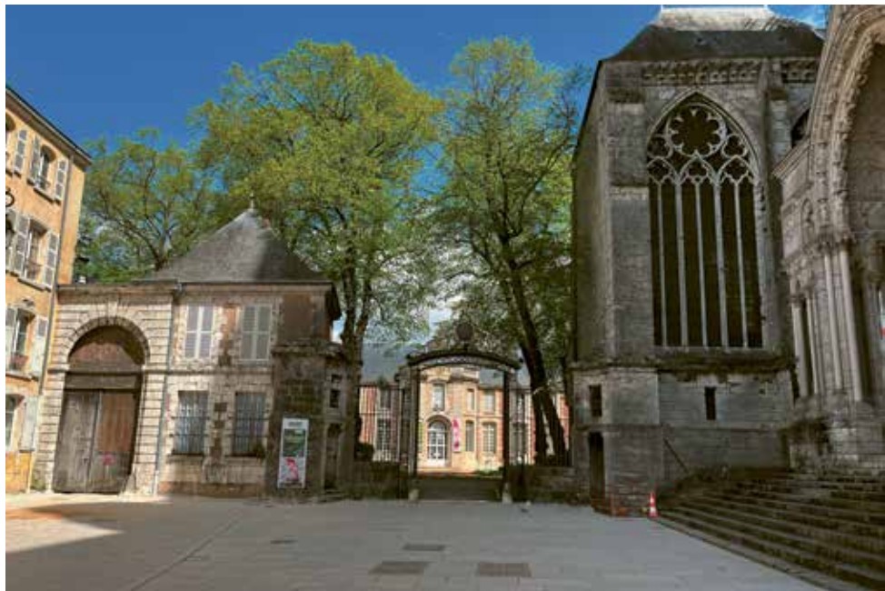
Le portail nord, terminé.
