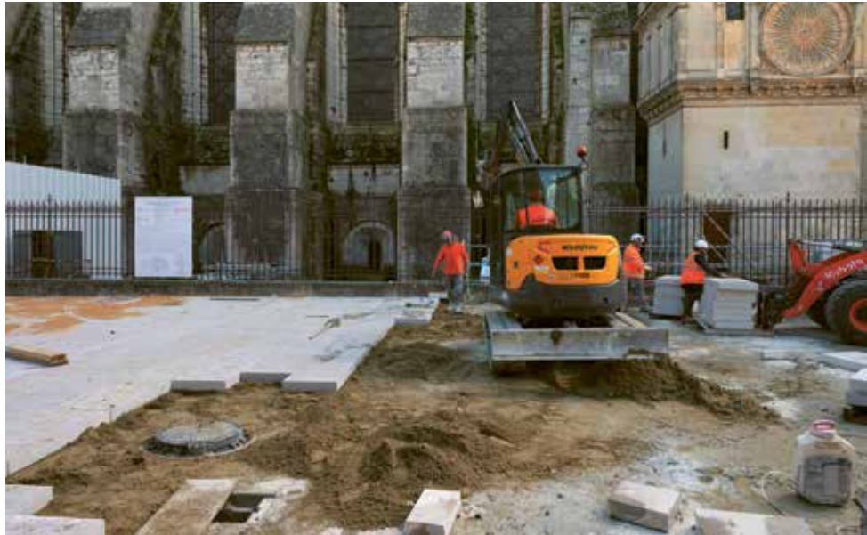
La pose des dalles.
