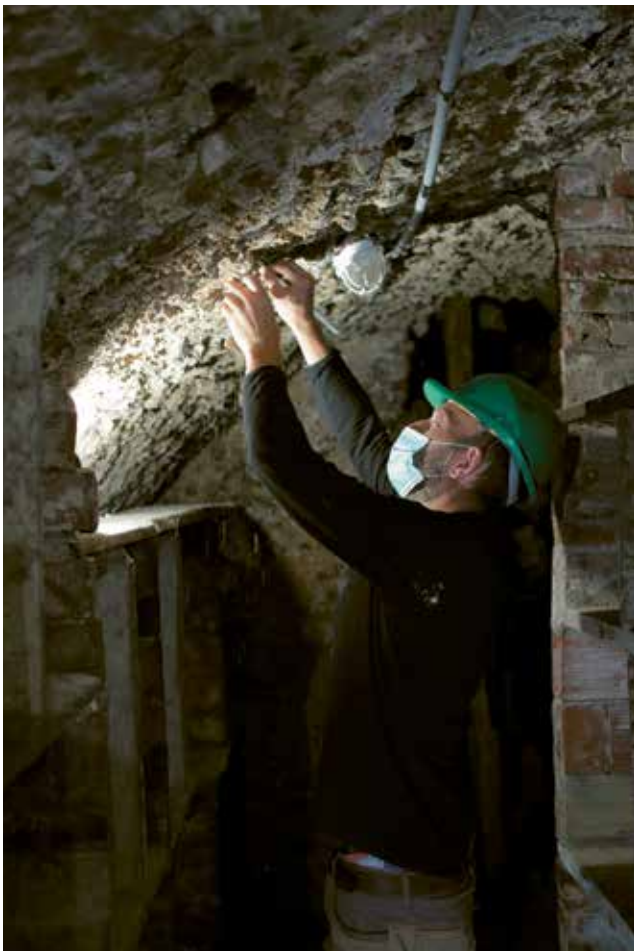
Services en cours d'inspection d'une cave.
