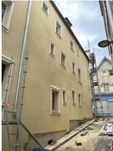
Photo réalisée après les interventions.
