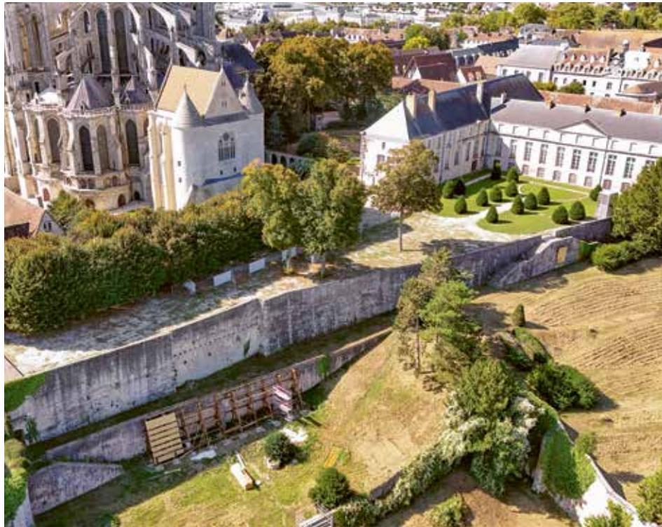
L'installation de dix contreforts en bois crée une structure capable de stabiliser les terrasses et soutenir l'ouvrage.
