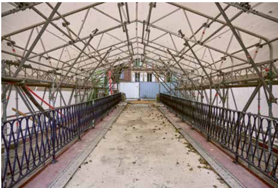
| Les travaux de la passerelle sont en voie d'achèvement.
