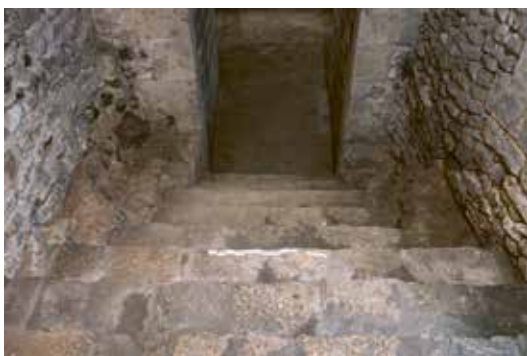
Vue de l'escalier d'accès sud à la crypte.
