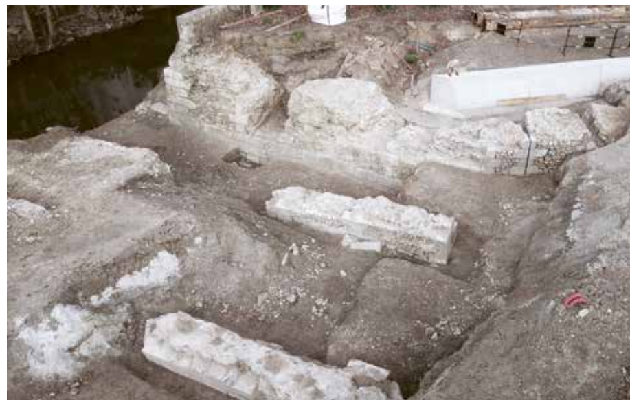
| Les fouilles ont révélé les restes d'un ravelin du XVI e siècle, qui servait à protéger les fortifications de la ville.
